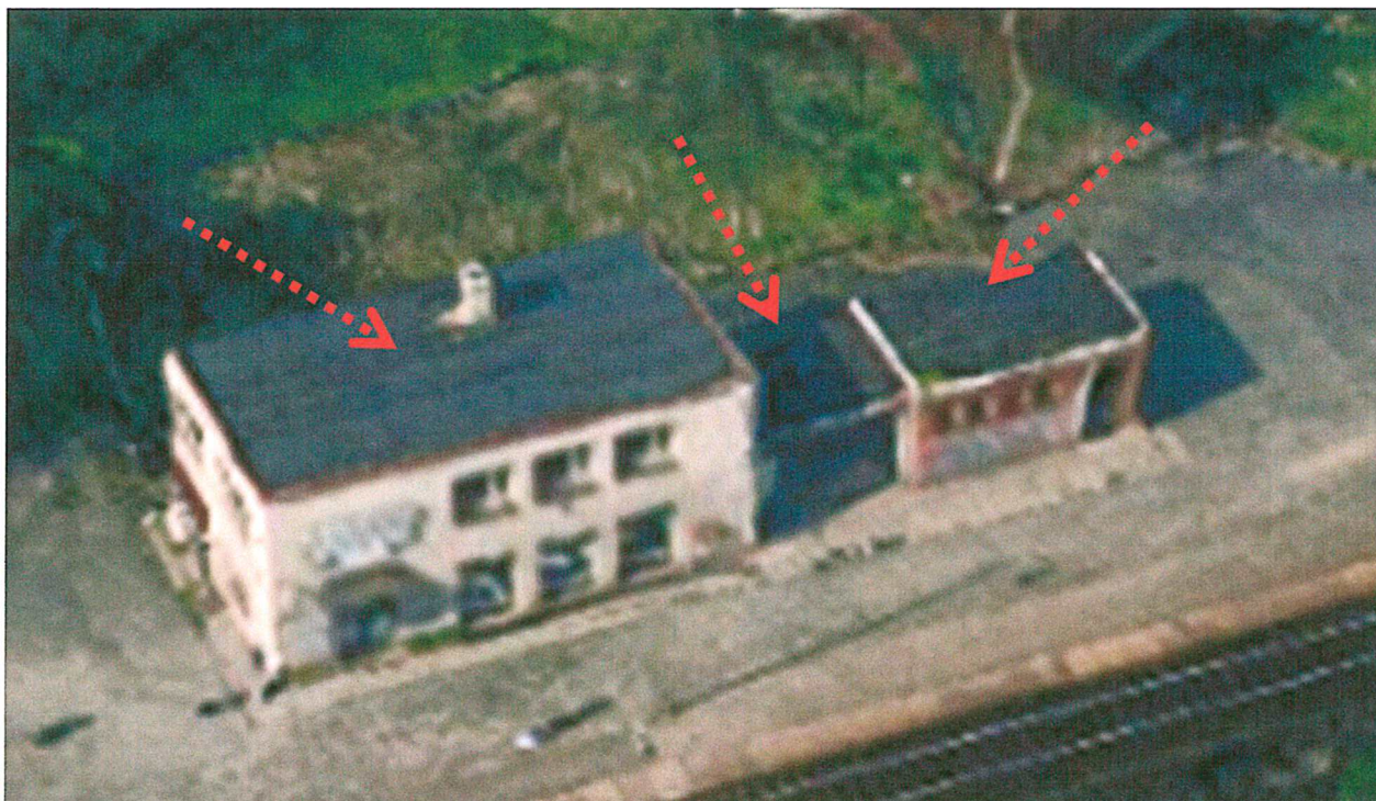
Foto č. 2 (zdroj: https://mapy.cz/ ) - Asfaltové pásy jako střešní krytiny všech tří částí výpravní budovy.
